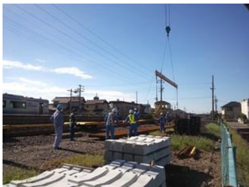
マクラギ更换工事
